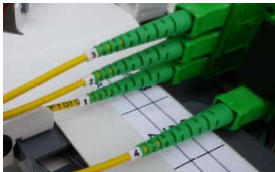
Figure 16. Exemple pose de cavalier sur cordon
