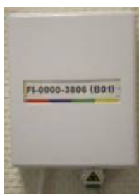
Figure 8 : FTTE passif au NRO - exemple de PTO
