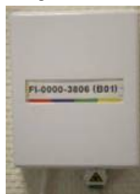
Figure 6 : FTTE passif au PM - exemple de PTO
