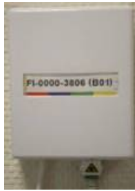
Figure 8 : FTTE passif au NRO - exemple de PTO
