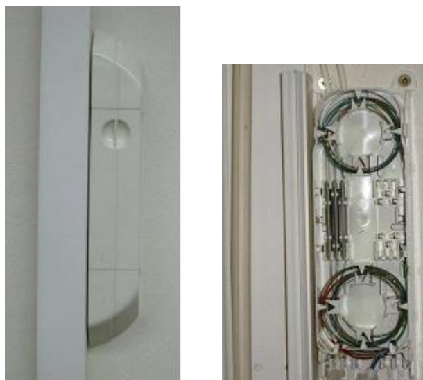
Figure 8 : point de branchement optique : PB Be-Box Acome
