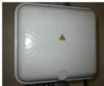
Figure 6 : Point de Branchement Optique, 3M Intérieur-extérieur
