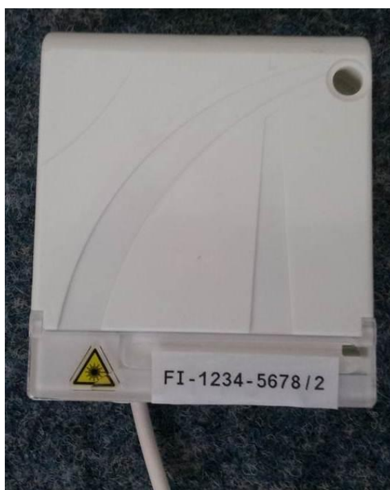
Figure 3 : repérage de la PTO déportée
